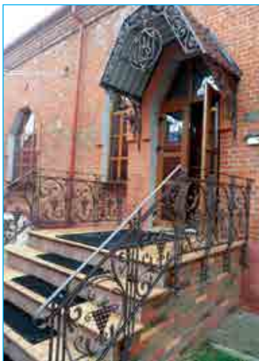
Оформлення кованими решітками входу в будинок
