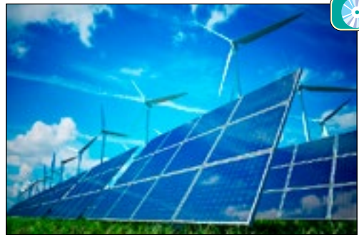
Мал. 4.4. Сонячна і вітрова електростанція у Нідерландах
