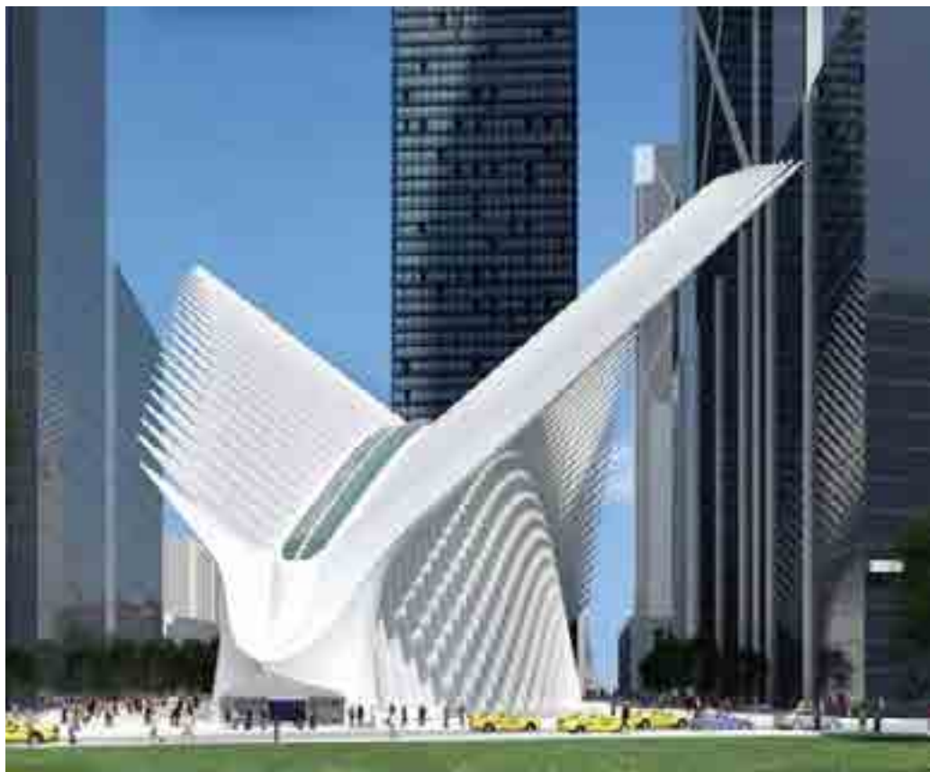
С. Калатрава. Станція Нью-Йоркського метрополітену
