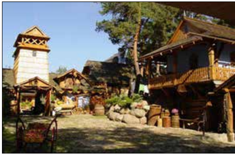
Реконструкція центральної садиби фільварку
