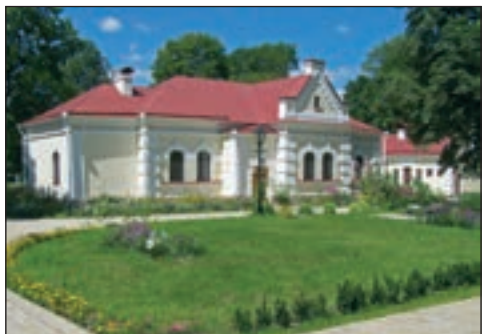
Будинок Кочубея в Батурині (сучасний вигляд)
