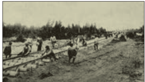
Будівництво Транссибірської залізниці
