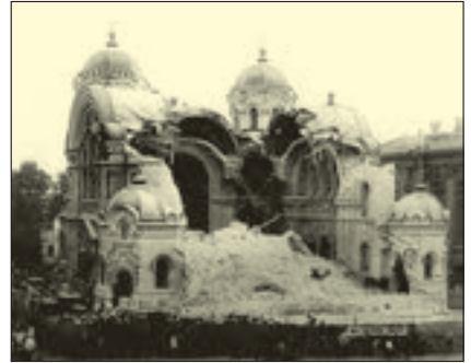
Зруйнування церкви у Харкові
