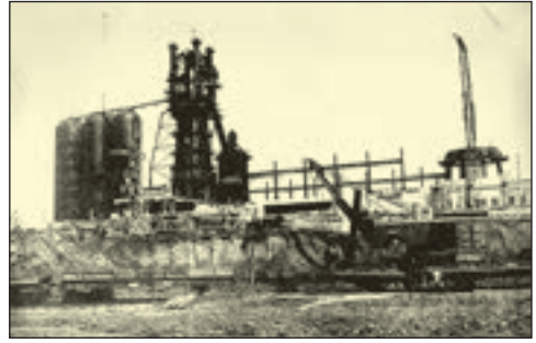
Доменна піч «Азовсталі»
