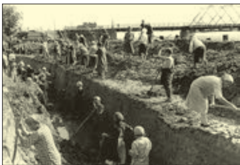
Цивільне населення на будівництві протитанкових укріплень, 1941 р.
