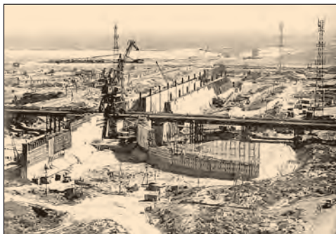
Будівництво Каховської ГЕС. 1953 р.
