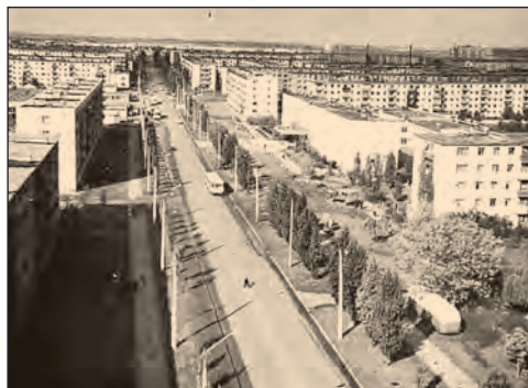
Мікрорайон, забудований «хрущовками»
