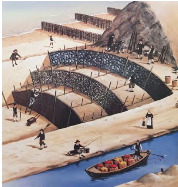
Будівництво дамби, яка відгороджує низини від моря
