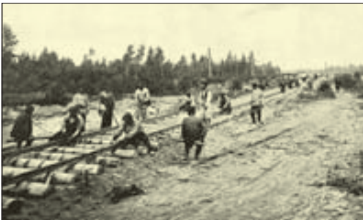
Прокладання Транссибірської магістралі. Фотографія Івана Томашкевича, 1898 р. У будівництві взяло участь 20 тис. робітників, які здебільшого працювали вручну, з мінімумом технічних засобів. Прокладання залізниці тривало впродовж 1891–1916 рр. і йшло зі швидкістю 600 км на рік
