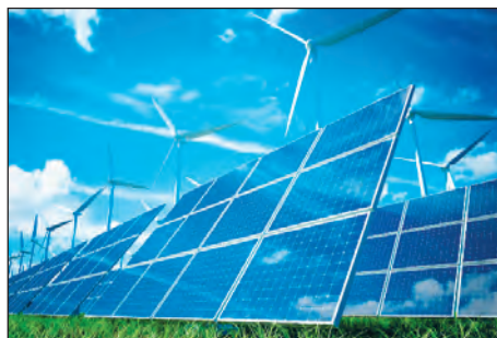
Мал. 6.2. Сонячна і вітрова електростанція у Нідерландах
