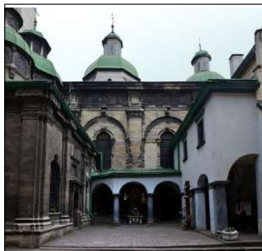
Будівля Львівської Успенської церкви при якій було створено першу братську школу 1463 р. Сучасне фото
