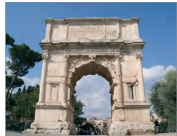
Тріумфальна арка Тита. I ст. Рим
