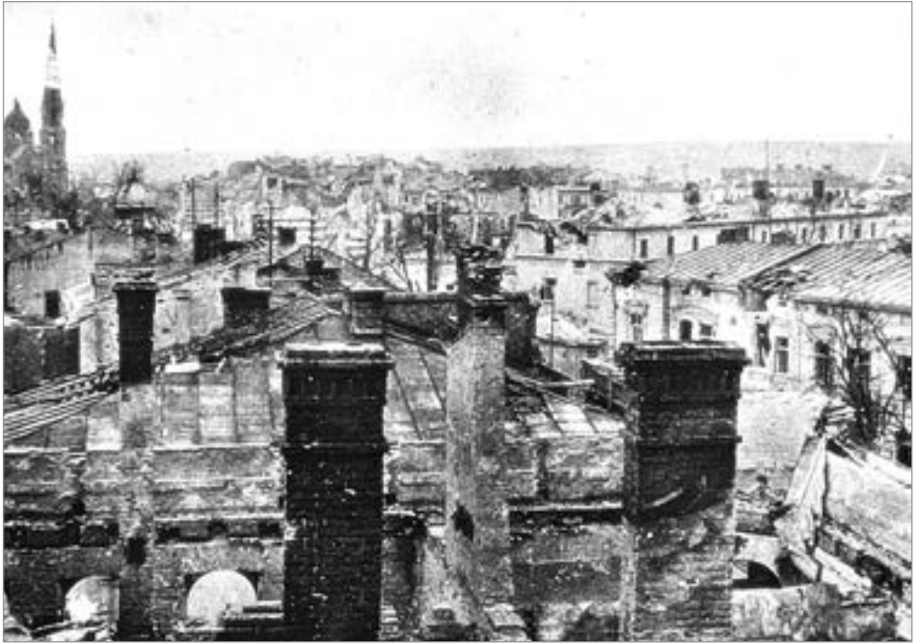
Дахи будинків на вул. Тарновського. Зліва — Парафіяльний костел. Вид зі сходу. Травень 1944 р.
