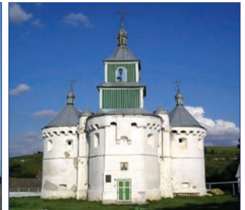
Покровська церква. с. Сутківці, Хмельницька обл.
