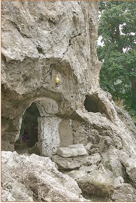
Рис. 3. Тріщини печери і часткове руйнування
